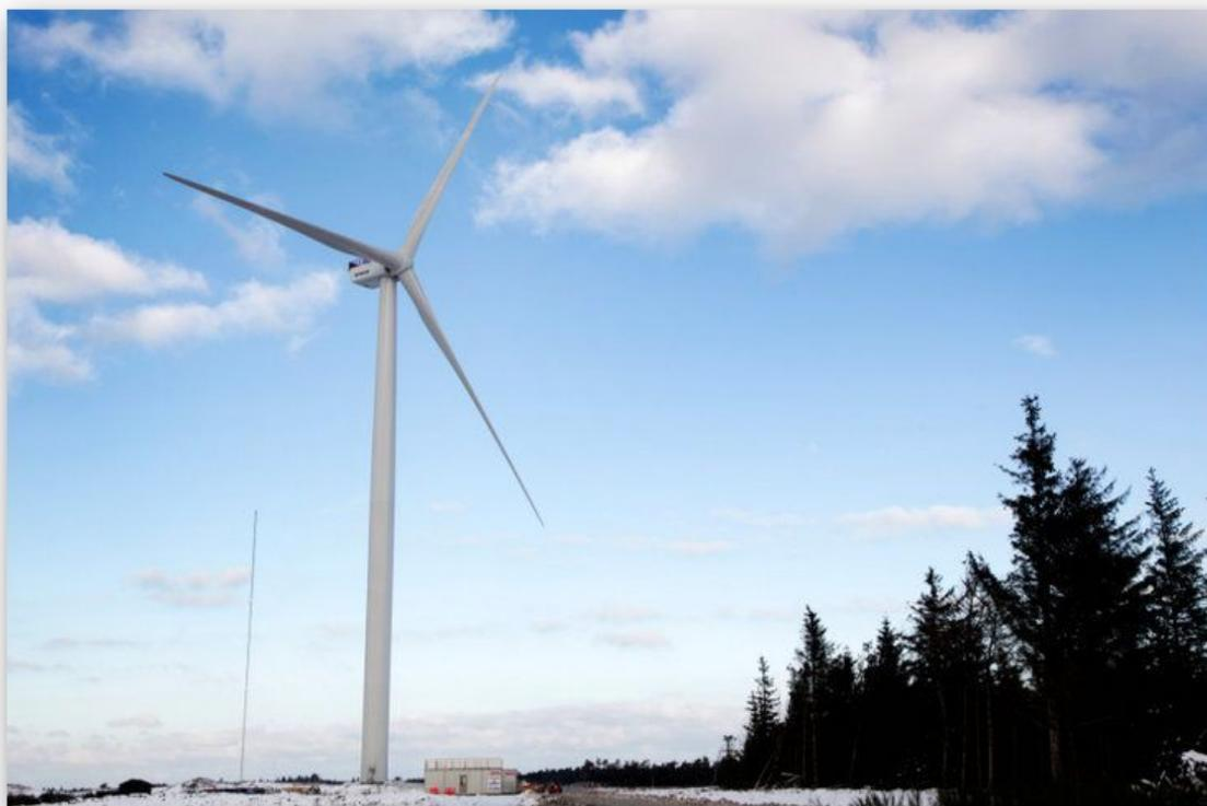
Vestas V-164 – самый мощный ветрогенератор на сегодня. Он вырабатывает 8 МВт. Для производства электричества в промышленных масштабах используются ветровые электростанции, состоящие из множества ветряков. Крупнейшей является электростанция «*Альта*», расположенная в Калифорнии. Её мощность – 1550 МВт.
